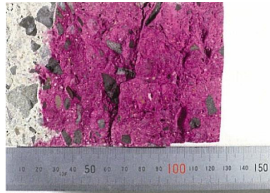
写真④ 中性化深さ（無色の部分）
