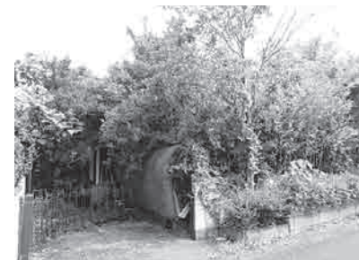
家屋が樹木に隠れた状況の空家
