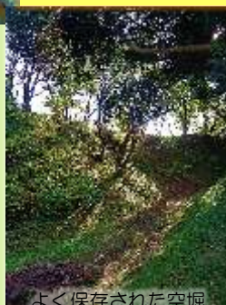
よく保存された空堀
