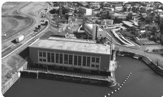
昭和31年に建設された中央公民館の向かいにある手賀排水機
