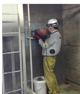
①コンクリートコア採取の状況
