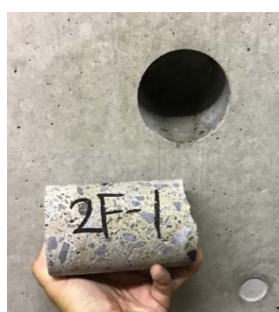
②採取したコンクリートコア
