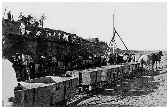
【利根川の改修工事】
