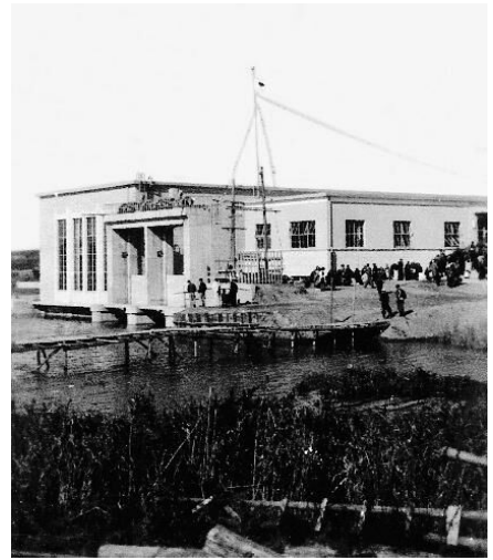
【手賀排水機場】
