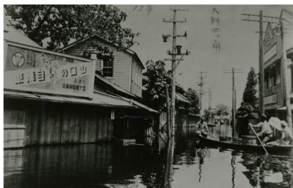
【昭和 13 年の水害】（六軒四つ角付近）
