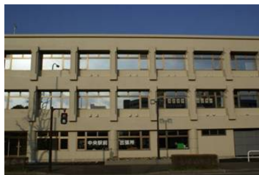
図 13 中央駅前地域交流館 2号館
