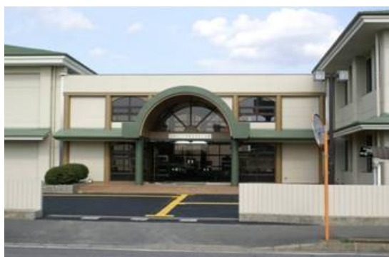
図 12 中央駅前地域交流館 1号館
