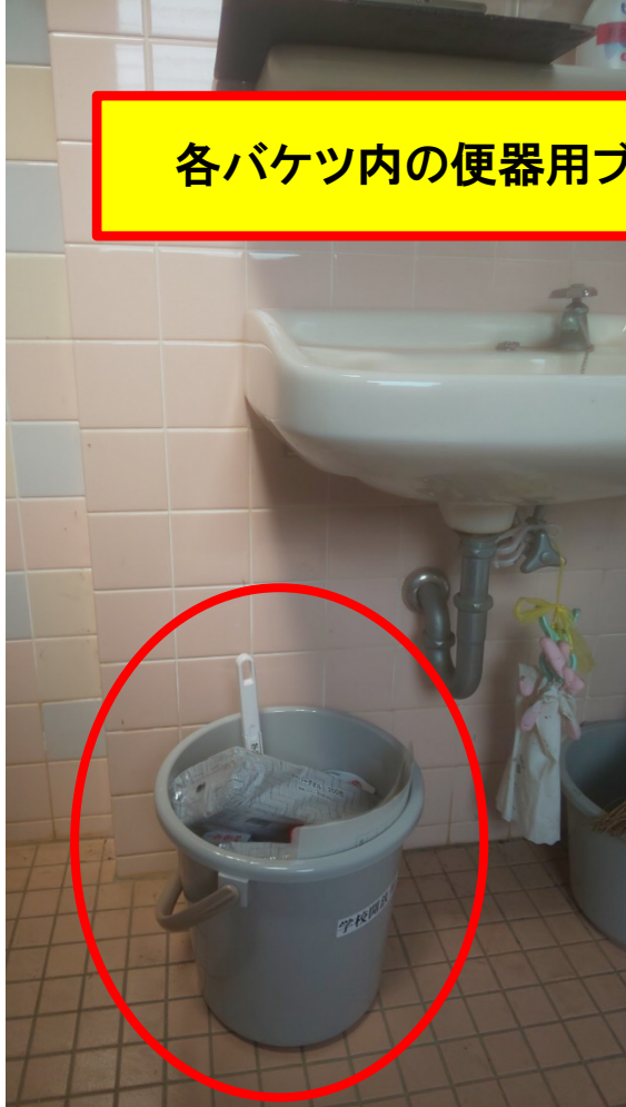
▲校庭の女子用外付けトイレ内に設置
