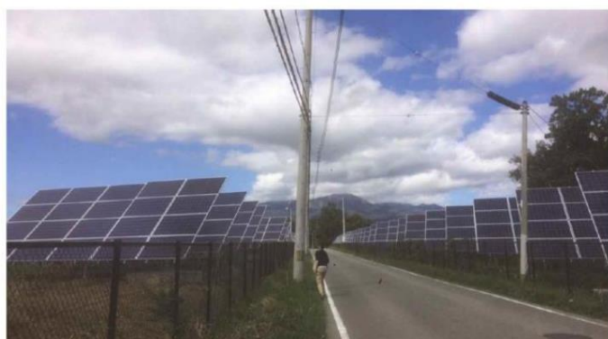
山岳パノラマ景観を阻害している事例
