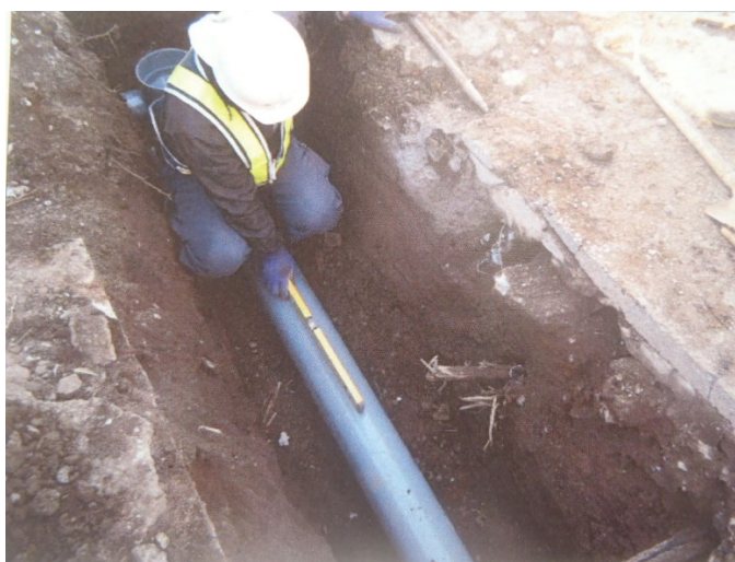
図 3-4 汚水管渠布設工事
