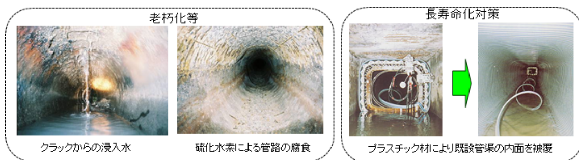
図 3-2 老朽化した管きょ
