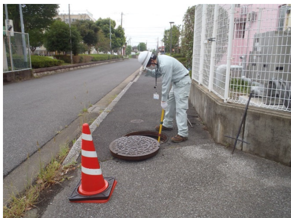
図 3-1 人孔内部の点検
