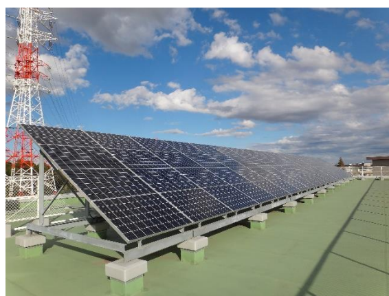
市内小学校の屋上に設置された太陽光発電設備
