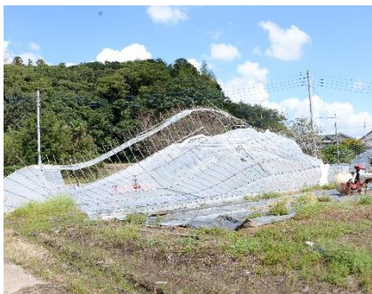
ビニールハウスの損壊
