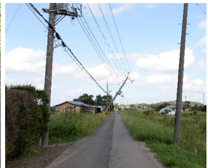
電柱の倒壊
