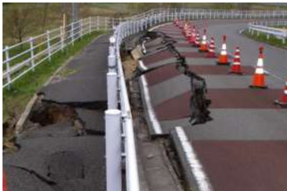
平岡地先における道路陥没
