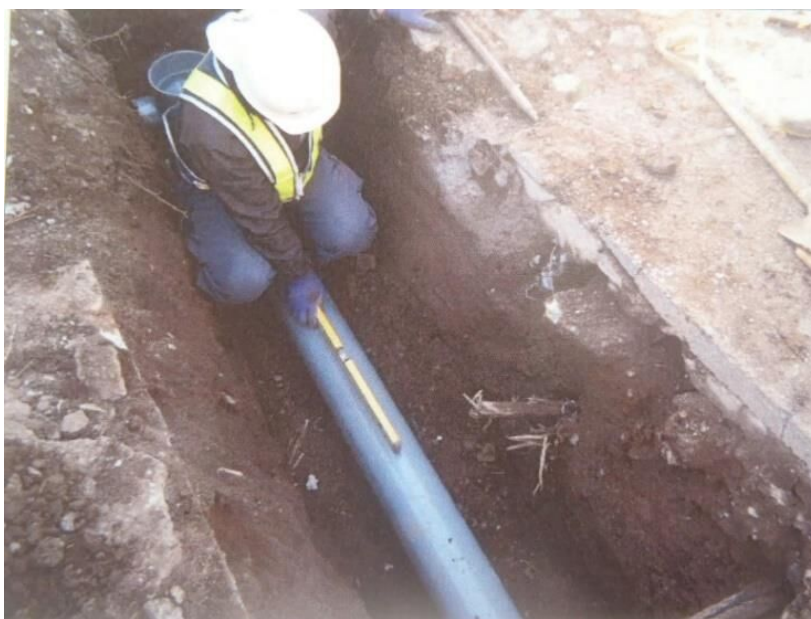
図 3-1 1 汚水管きよ布設工事の様子
