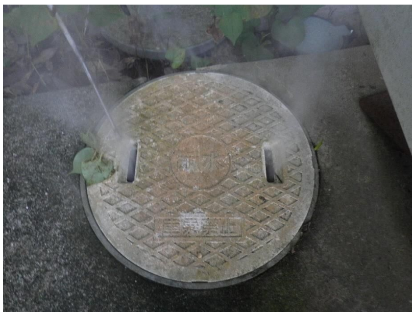
図 3-6 送煙調査（不明水対策）
