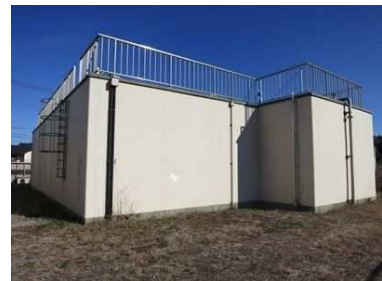
印旛配水場(配水池)
