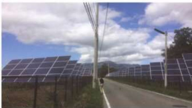
山岳パノラマ景観を阻害している事例
