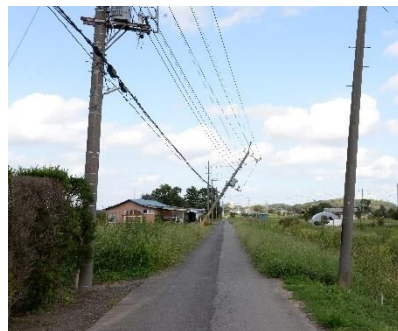
電柱の倒壊
