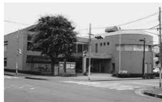
改修工事を行う小林コミュニティプラザ
