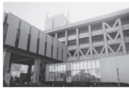
耐震改修と増築を重ね築46年になる市役所本庁舎
