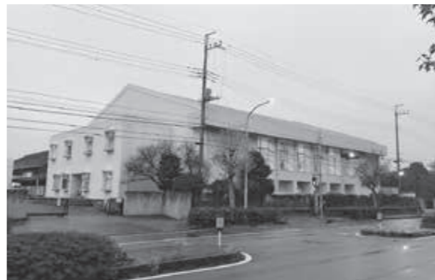
木刈中学校の体育館
