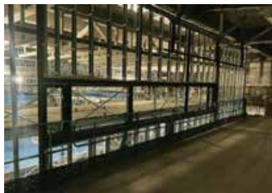
建設中の芸術ホール
