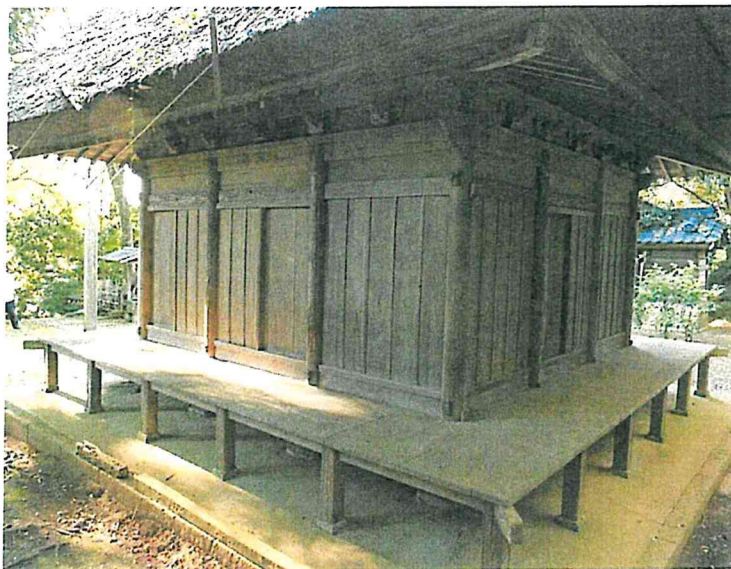
修理前 正面左側軸部
