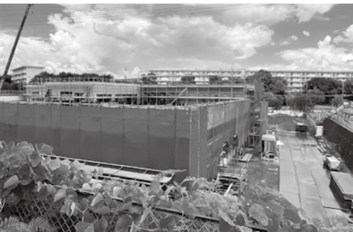
建設が進む高花学校給食センター
