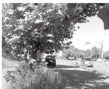
繁茂した樹木で見えにくくなっている信号機
