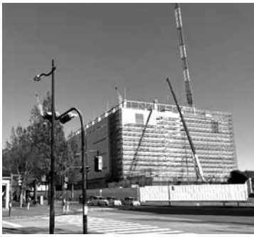
ビッグホップ西南側に建設中のデータセンター
