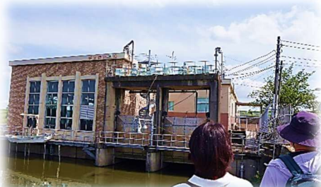
東洋一を誇った手賀沼排水機場
