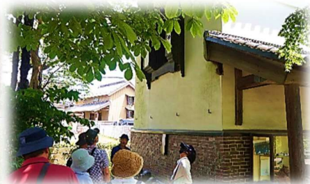
河岸問屋吉岡家の倉庫
