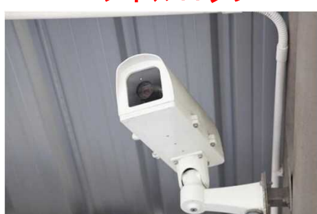
防犯カメラ設置
