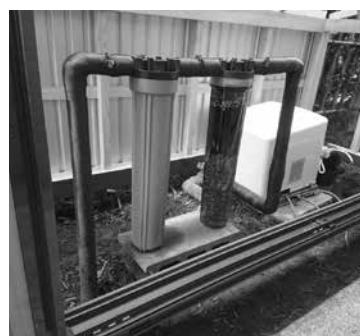
井戸水の水質浄化装置
