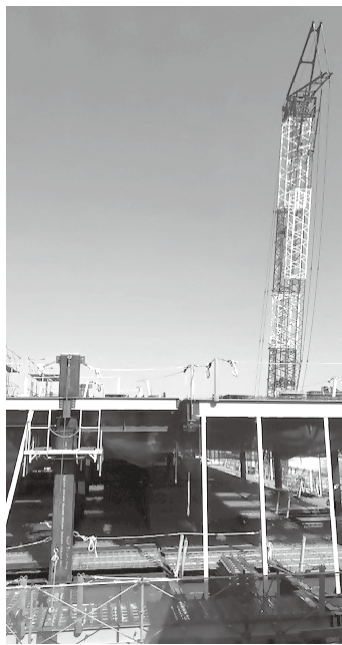
建設工事中の （仮称）千葉ニュータウン中央駅圏 複合施設
