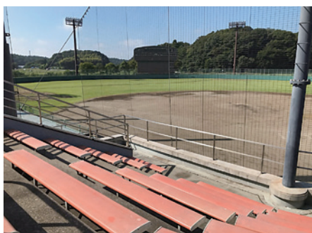
保全改修工事を行う松山下公園野球場
