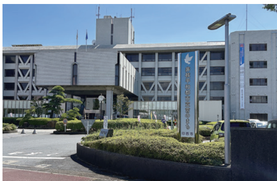
老朽化が進む印西市役所本庁舎
