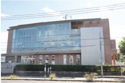
改修及び増築が予定されている印旛支所
