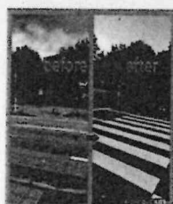
【横断歩道の修復】 滝野:6か所 牧の原:4か所
