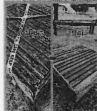
【公園のベンチ改修】 滝野：ひかりの おか公園 3台
