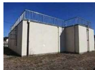
<印旛配水場(配水池)>
