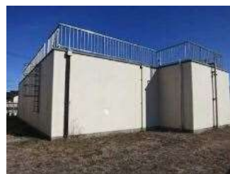
<印旛配水場(配水池)>
