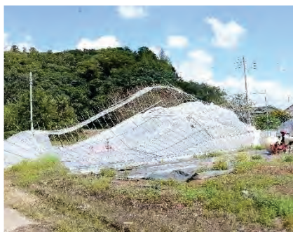
ビニールハウスの損壊
