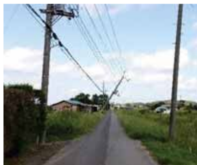
電柱の倒壊
