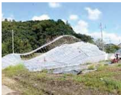
ビニールハウスの損壊
