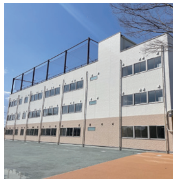
原小学校の増築棟
