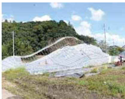
ビニールハウスの損壊
