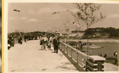
舟戸大橋完成 昭和38(1963)年3月23日 竣工式 佐倉市所蔵
