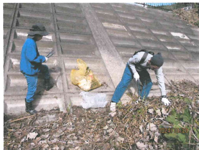
道路下には、ごみが捨てられ続けている。
