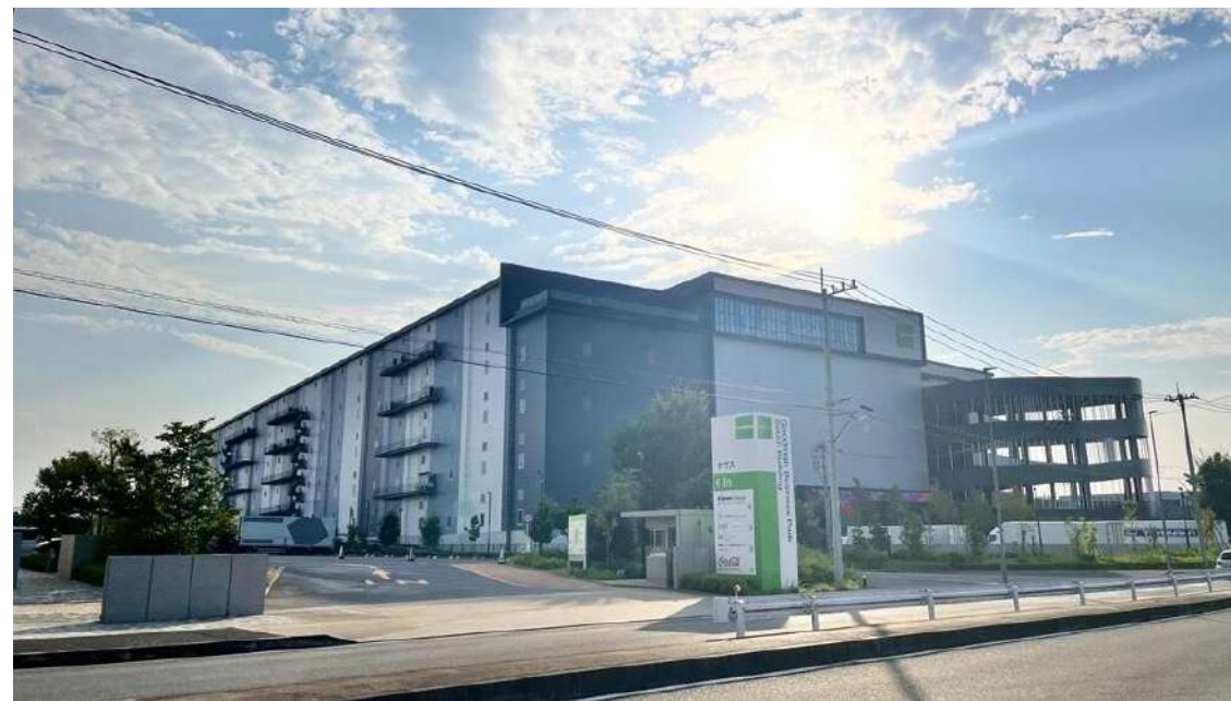
グッドマンビジネスパーク (総賃貸面積80ha超、データセンター、物流拠点が集積)
