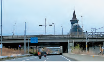
成田空港と印西市を結ぶ 北千葉道路（国道464号）
