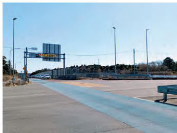
4車線化が求められる北千葉道路暫定開通区間
