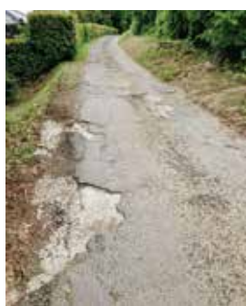
師戸区市道岡台・内野線アスファルト打ち替え工事予定場所の現況
