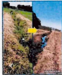
【農地の用水路対策】 ●草深 畦道が破損した農地用水路の補修
