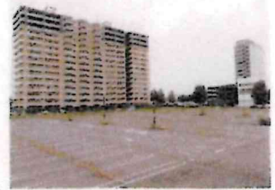
中央駅徒歩5分のDC建設予定地
