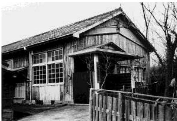
写真4 昭和30年代後半 永治公民館
