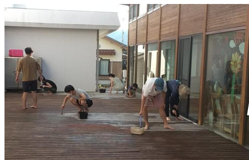
図書館テラスのペンキ塗り作業
