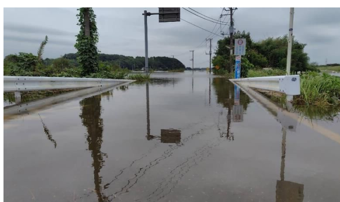
船戸大橋付近の冠水
