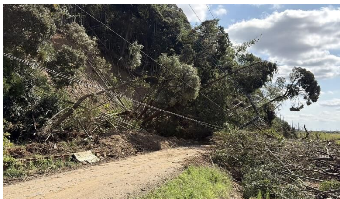
瀬戸地区の土砂崩れ
